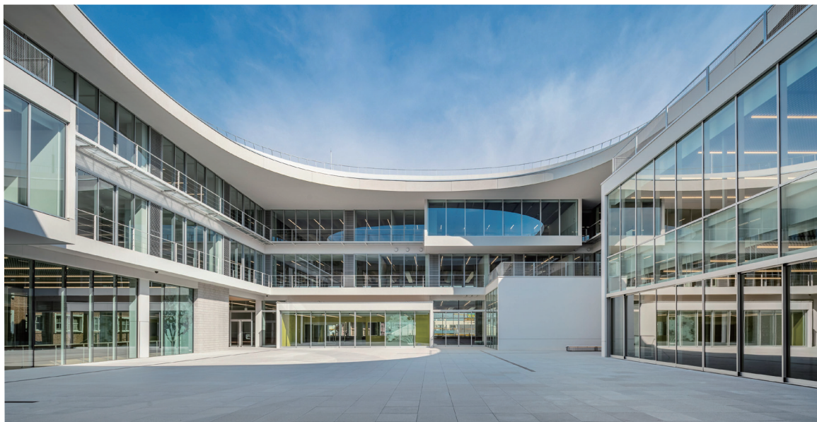
八潮市役所 八潮市保健センター 様 (2023年10月竣工)
